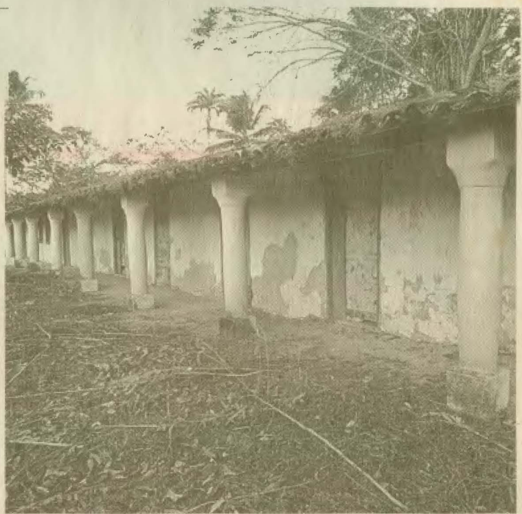
Senzala está preservada, mas apresenta sinais de deterioração
